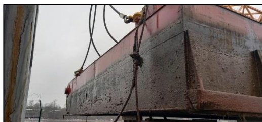
Фото 7.6. Плавучее ремонтное заграждение (батопорт).
