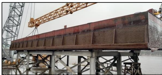
Фото 7.1. Плавучее ремонтное заграждение (батопорт).
