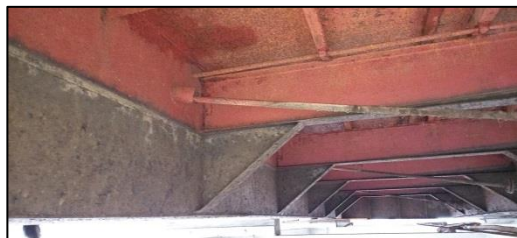
Фото 7.24. Плавучее ремонтное заграждение (батопорт).
