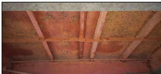
Фото 7.23. Плавучее ремонтное заграждение (батопорт).
