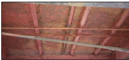
Фото 7.21. Плавучее ремонтное заграждение (батопорт).
