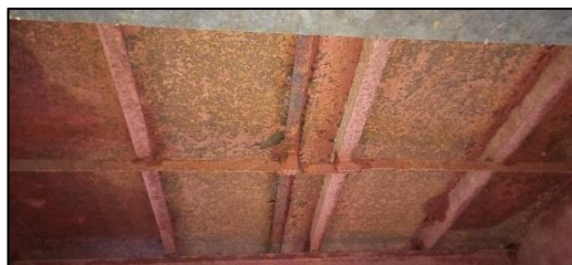
Фото 7.22. Плавучее ремонтное заграждение (батопорт).
