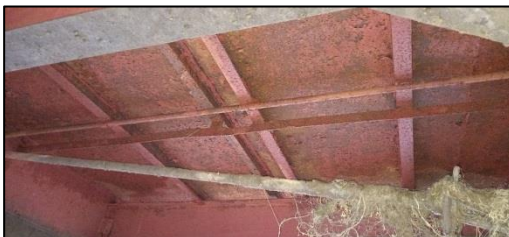
Фото 7.19. Плавучее ремонтное заграждение (батопорт).
